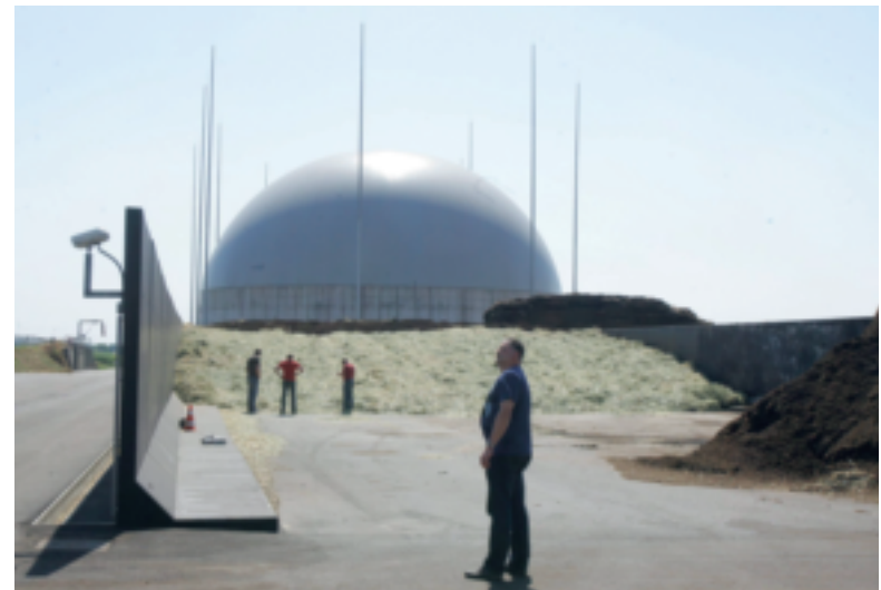
Die Biogas-Großanlage erzeugt Gas für rund 2.000 Haushalte
